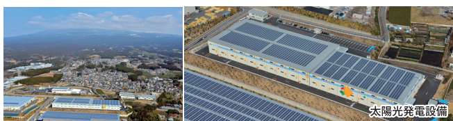
太陽光発電設備
