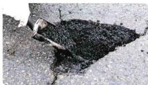
アスファルト舗装の ひび割れや穴の補修
