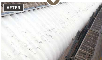
劣化し表面が剥がれた屋根を補修・補強
