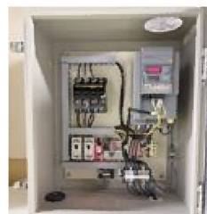
機械室に設置しているBA CLOUD本体
